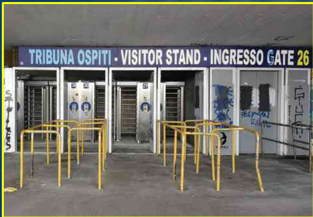
N. 6 tornelli integrati con lettore codice a barre e videocamera
